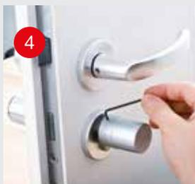
4 Befestigen des Drehknafs mit dem mitgelieferten Inbusschlüssel.
