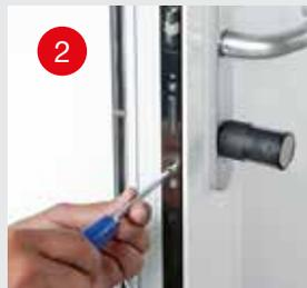
2 Den elektronischen TSE-Profil-Zylinder mit der Tür wie gewohnt verschrauben.
