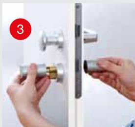
3 Anpassen an die Türstärke mit dem integrierten Rastsystem.
